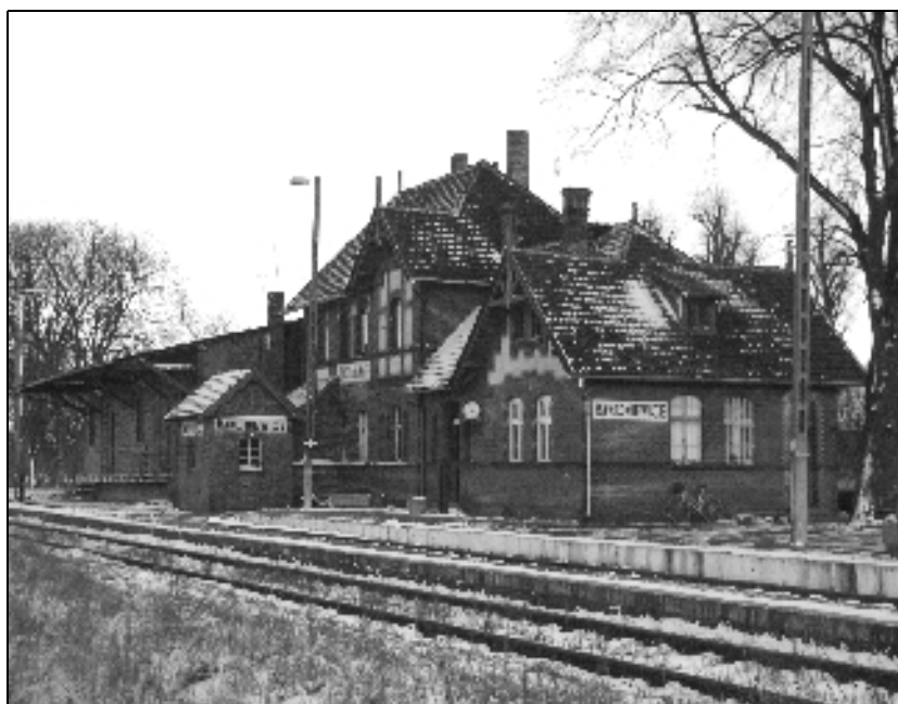
Budynek PKP – zima 2008 r. 90 lat od wybuchu Powstania Wielkopolskiego budynek w zasadzie pozostał niezmieniony z jednym małym lecz jak symbolicznym wyjątkiem. Nazwa „Rakwitz” symbol pruskiego jarzma została zastąpiona słowem „Rakoniewice”
